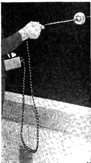
Рис. 153. Замер температур поверхности ограждающих конструкций термощупом
